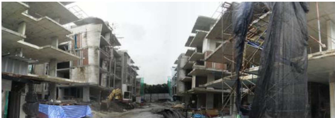
ภาพที่ 8 พื้นที่ก่อสร้างโครงการหอพัก เอ็มบี – รามอินทรา
